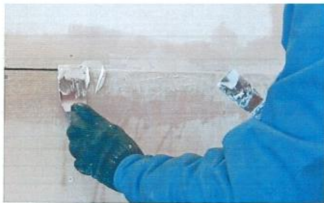
Fig. 2 Modul de chituire a plăcilor „MAGNECO PREMIUM”
